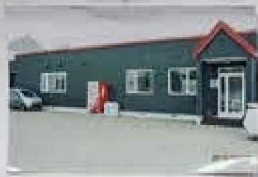
ここは事務所です。 ↑ この大きな蒸気機は、↑ 余った熱を外に出すはたらきをします。
