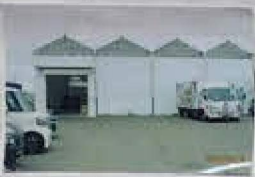
ここは運来・集荷が行われ、 たり、段ボールやロックウールなどの 資材置き場となる場所です。ハウスは、右奥です。
